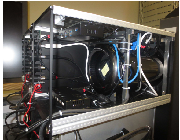
Kundensystem während der Installation
